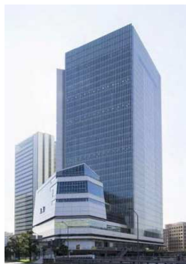
横浜市新市庁舎外観
